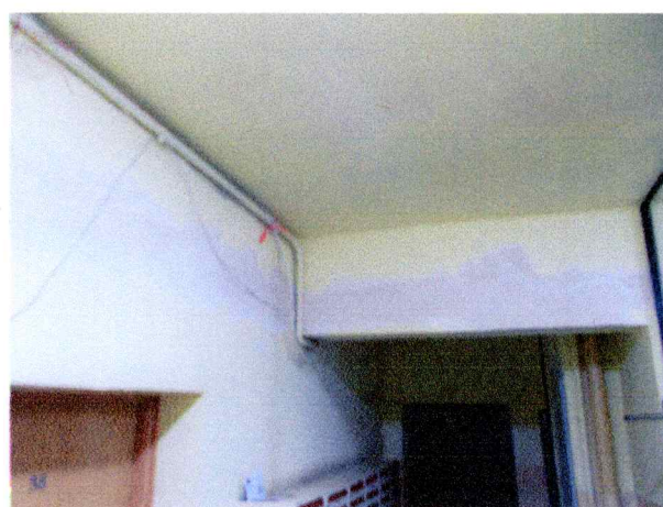
Przespachlowania ścian klatki
