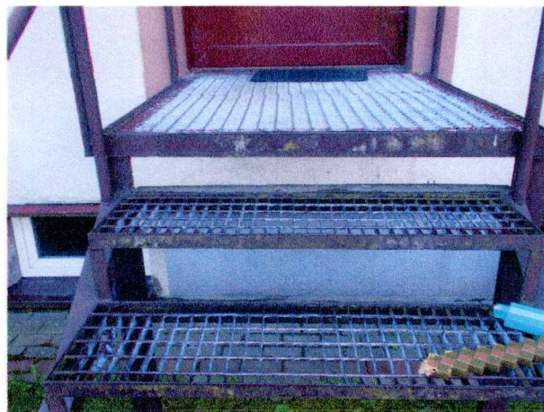
Schody do biura SM
